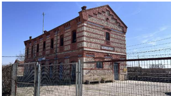
Figura 7: Vista del edificio de viajeros de la estación de Río Zancara, construido en 1929. Fotografía tomada el 1 de marzo de 2026.
