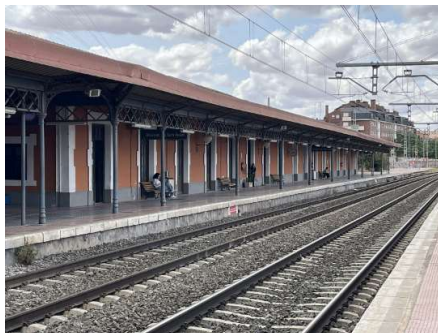
Figura 1: Vista del edificio de viajeros, desde el lado de Levante, erigido en 1854 y ampliado en 1860 y 1889. Fotografía tomada el 14 de mayo de 2024.
