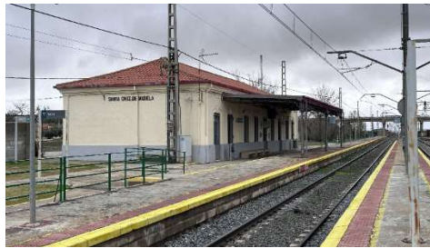
Figura 23: Vista del edificio de viajeros de la estación de Santa Cruz de Mudela. Fotografía tomada el 7 de marzo de 2026.
