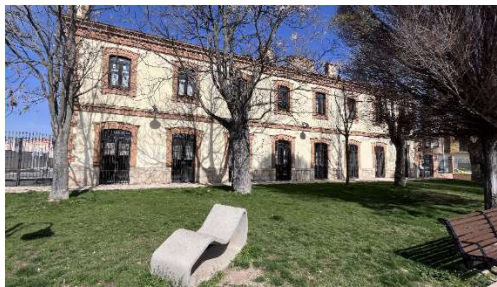
Figura 29: Vista del edificio de viajeros de la estación de Tomelloso. Fotografía tomada el 1 de marzo de 2026.
