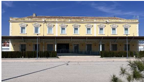
Figura 8: Vista del antiguo edificio de viajeros de la estación de Socuéllamos, proyectado en 1926. Fotografía tomada el 1 de marzo de 2026.
