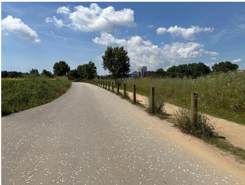
Figura 11. Antiguo trazado del ferrocarril Mollet-Caldes reutilizado como camino en el entorno del Parque Gallecs en el municipio de Mollet del Vallès
