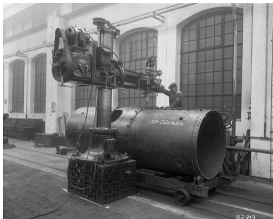
Figura 6. Refuerzo de agujeros de remaches en la caldera de fundición para locomotoras colombianas. 12
