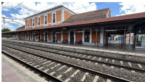
Figura 2: Vista del edificio de la fonda, desde el lado de Levante, erigido en 1854. Fotografía tomada el 14 de mayo de 2024.
