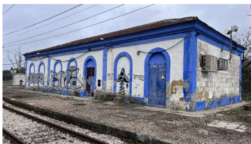
Figura 26: Vista del edificio de viajeros de la estación de Venta de Cárdenas. Fotografía tomada el 7 de marzo de 2026.
