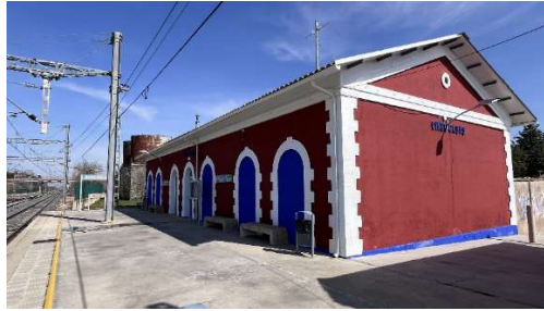
Figura 10: Vista del edificio de viajeros de la estación de Cinco Casas, construido en 1860. Fotografía tomada el 1 de marzo de 2026.
