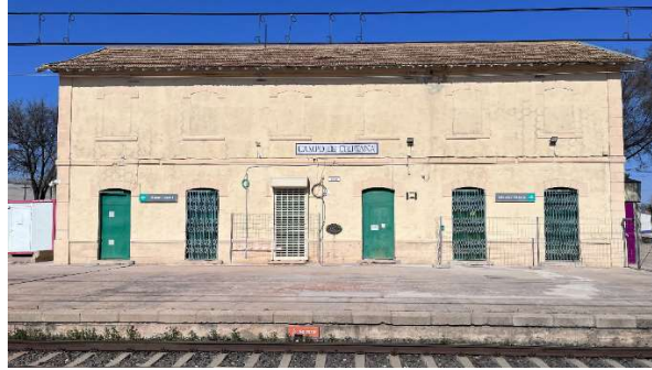
Figura 6: Vista del edificio de viajeros de la estación de Campo de Criptana, proyectado en 1908. Fotografía tomada el 1 de marzo de 2026.
