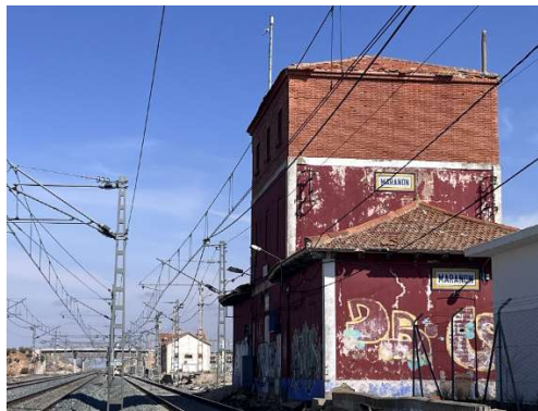
Figura 9: Vista del antiguo edificio de viajeros de la estación de Marañón. Fotografía tomada el 1 de marzo de 2026.
