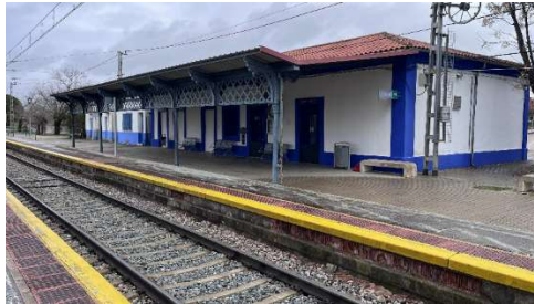
Figura 25: Vista del edificio de viajeros de la estación de Almuradiel-Viso del Marqués. Fotografía tomada el 7 de marzo de 2026.
