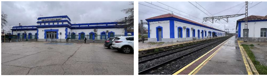
Figuras 13 y 14: Vista del pabellón de entrada al recinto ferroviario de Manzanares (izquierda) y del edificio ubicado en el andén isla (derecha). Fotografías tomadas el 1 de marzo de 2026.
