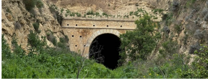
Boca sur del túnel de la Romera (fotografía de Javier Romero)
