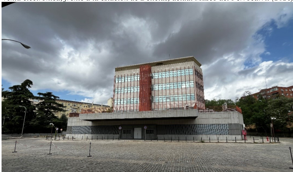
Figura 6. Vista general del acceso principal al antiguo vestíbulo y sala de pupitres de venta electrónica, frente a la estación de Delicias, actual Museo del Ferrocarril (2026)
