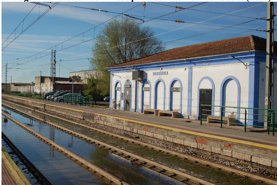
Imagen 1.- Estación de Villasequilla con las vías inundadas (2026).
