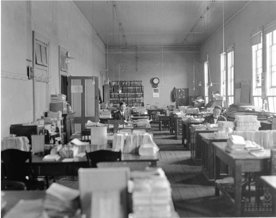
Imagen 1. Interior de la Oficina de ingresos de pasajes en el edificio tepetate, tabique y lámina, tres pisos, para oficina de la superintendencia de fuerza motriz y maquinaria. Estación Buenavista. Ciudad de México, 1926. Secretaría de Cultura. Centro Nacional para la Preservación del Patrimonio Cultural Ferrocarrilero. Centro de Documentación e Investigación Ferroviarias. Fototeca. Número de inventario 48303MX2022-03-000008.
