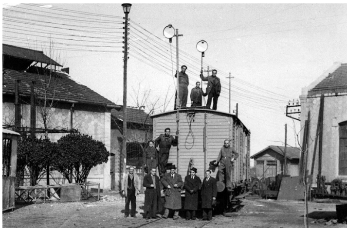
Personal ferroviario posando delante del vagón electrógeno nº 2 del Servicio Eléctrico de RENFE en Alcázar de San Juan. Servicio Eléctrico RENFE, década 1950. Sig. SE-OG-0011.
