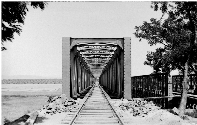
Nuevo puente sobre el río Guadiana Pk 166/333. Año 1927 43 . Foto F. Salgado.
