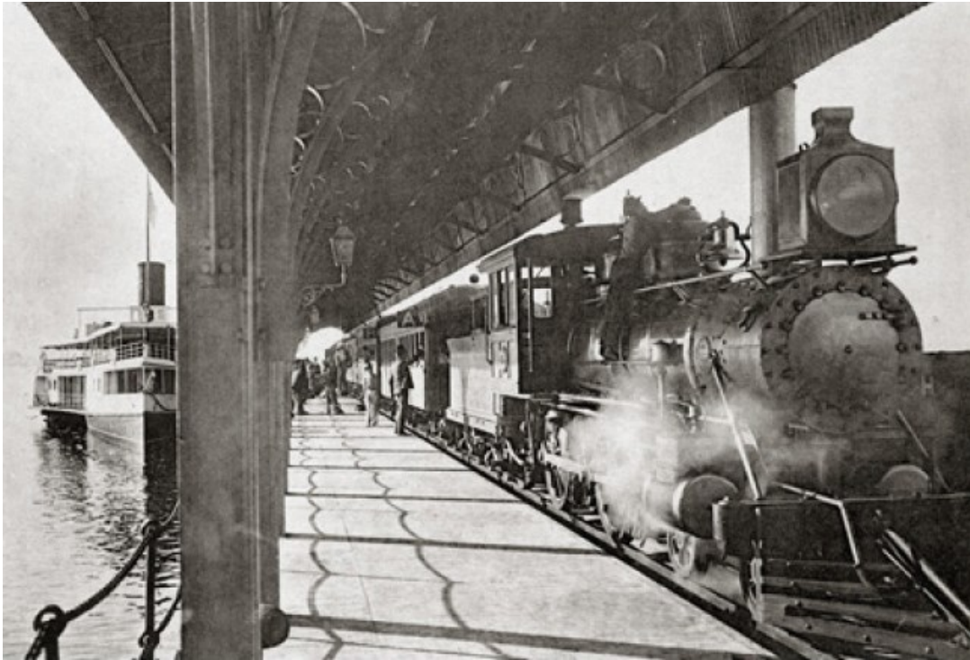
Figura 3 - La locomotora Baroneza, que conectaba con el transporte fluvial en Porto Estrela.
