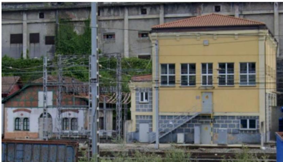
Ilustración 9: Subestación eléctrica y vivienda en la estación de Zumarraga. Fotografía del autor.
