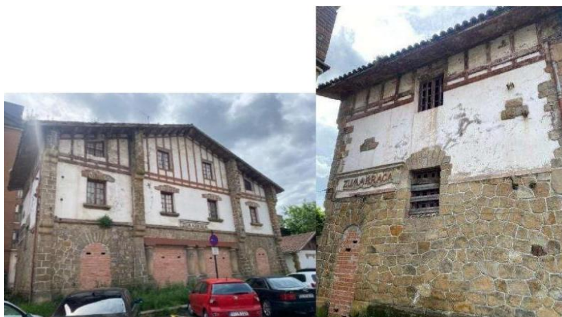
Ilustración 10: Edificio de viajeros de la estación de Zumarraga. Fotografía del autor.
