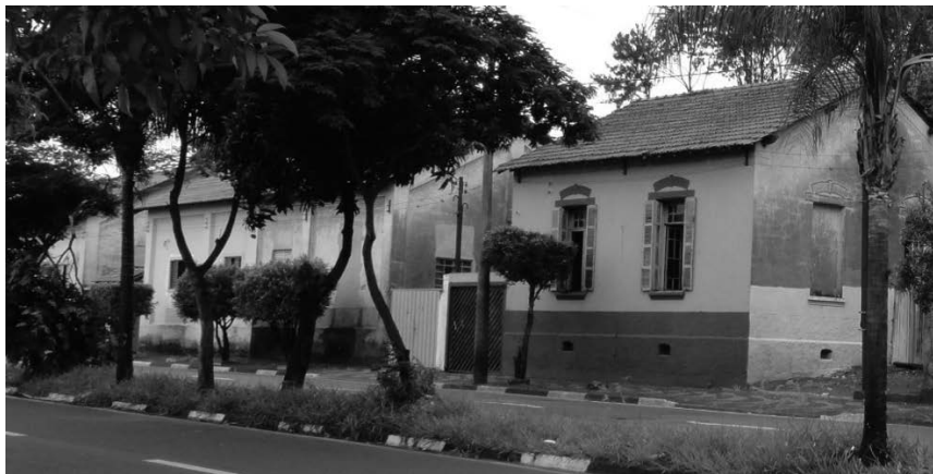
Figura 7 Edifícios das antigas residências operárias de Araras
