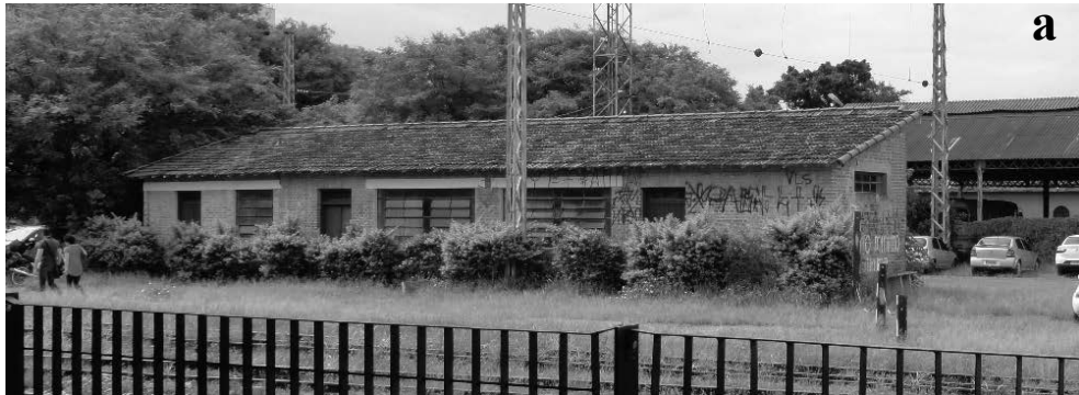
Figura 6 Edifícios ferroviários em Campinas (a) e São Carlos (b).
