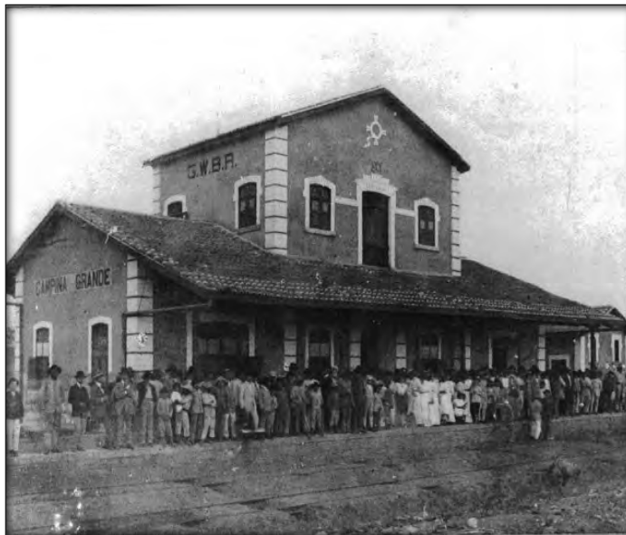
Figura 9 Estação Ferroviária de Campina Grande – 1907
