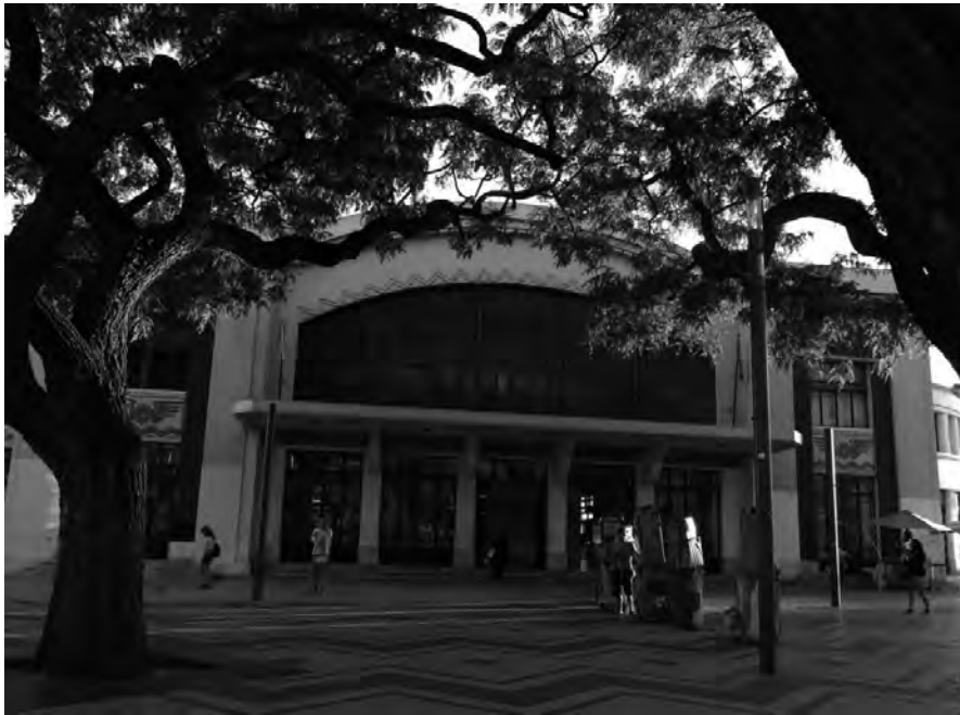
Imagen 4. Estación Cais do Sodré, entrada de la estación de 1928
