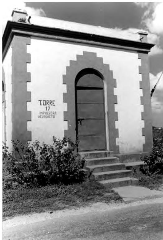
Figura 5. Una de las 3 torres cuadradas o casas de compuertas para el desagüe e inspección del canal de conducción
