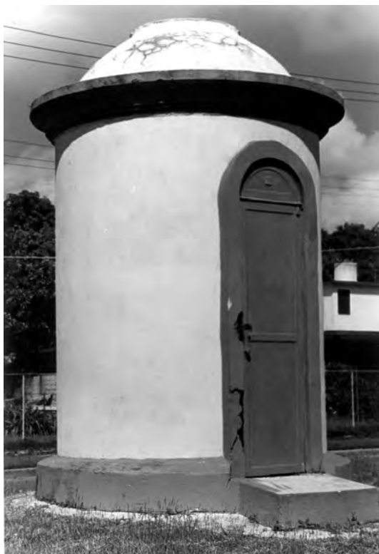
Figura 4. Una de las 24 torres cilíndricas que existen a lo largo del canal de conducción como registros ventiladores
