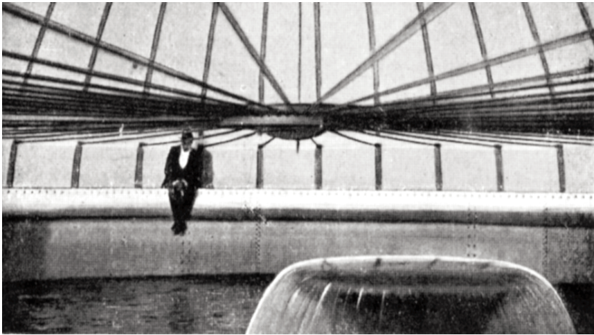
Ilustración 6. Entrada de agua al depósito, hacia 1912.
