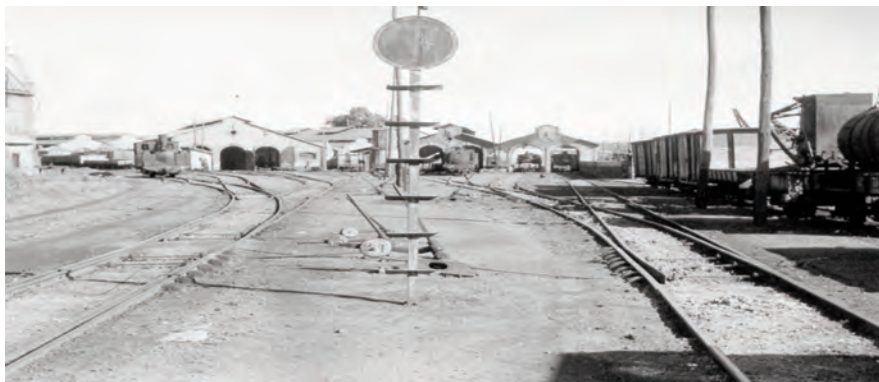
Figura 7. Talleres y cocheras de la estación de Peñarroya
