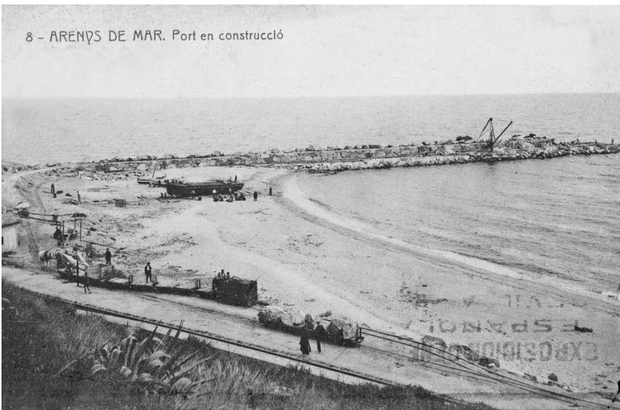
Construcción del muelle de Levante del puerto de Arenys de Mar, hacia 1929. Thomas, Barcelona, ftxn 1125
