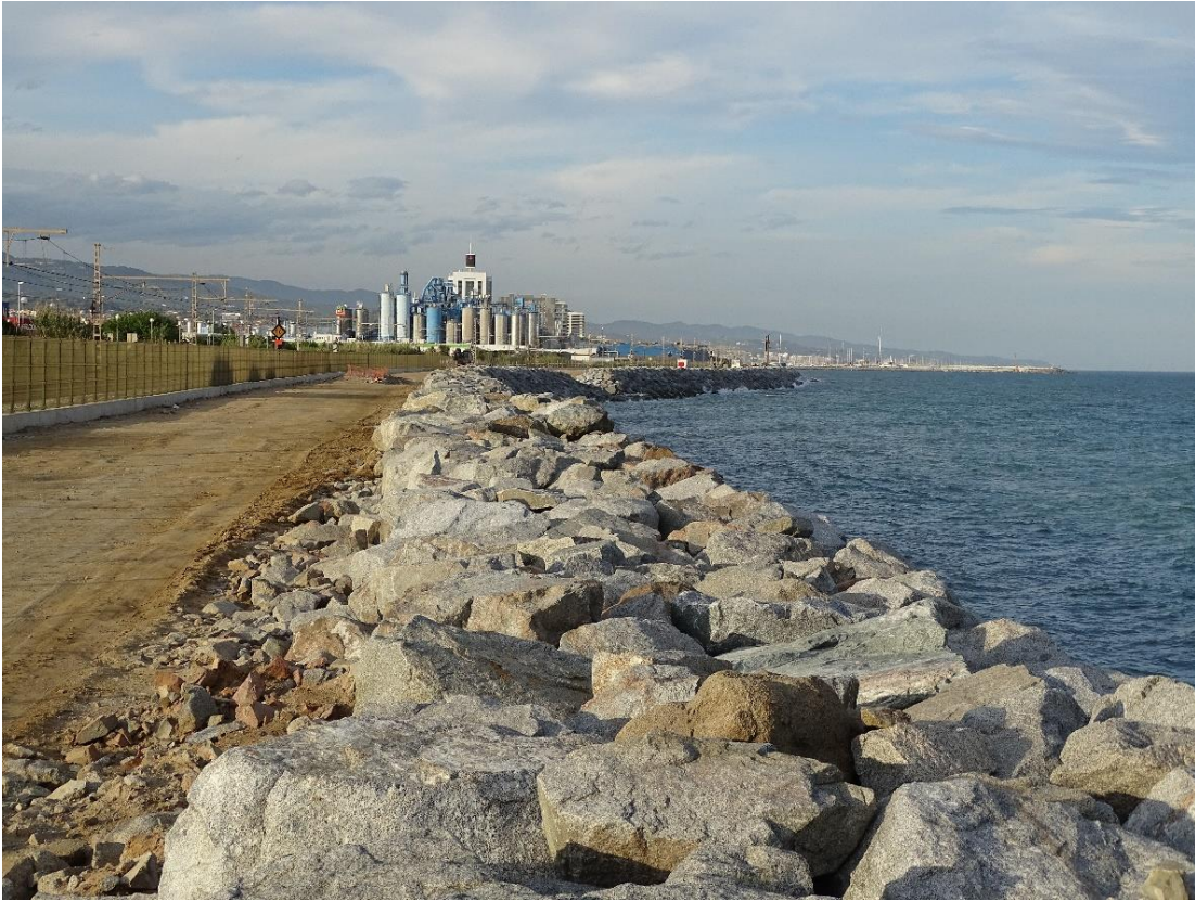
La nueva escollera reforzada con pilotes y franja protectora “aquí no hay playa”, en mayo de 2021. Foto autor
