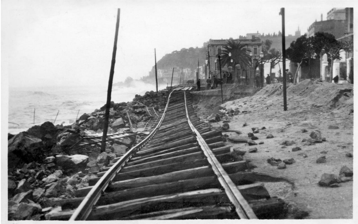
Destrozos del temporal en Arenys de Mar en marzo de 1932. Joaquim Castells, ftxn 1174
