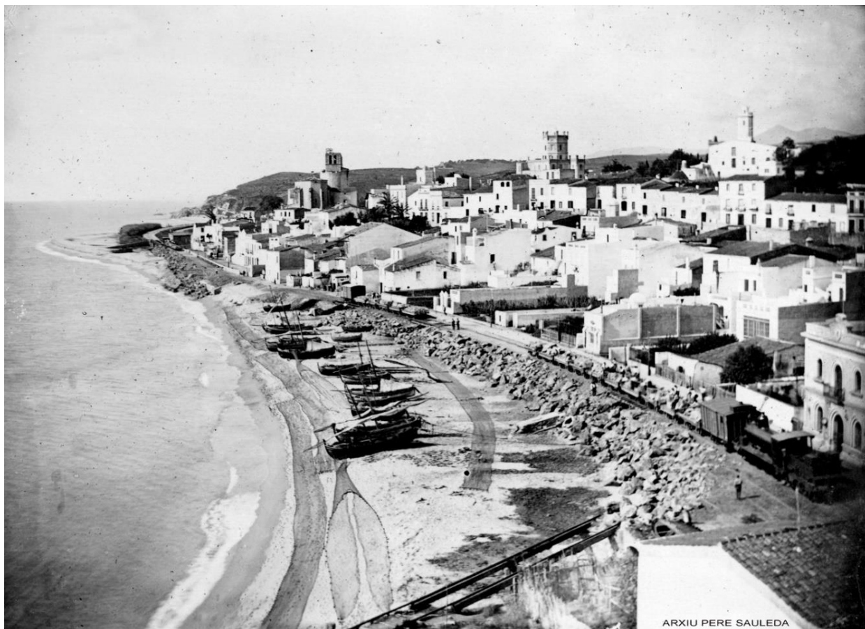
-San Pol- Desde el Ex sobre el túnel- Construcción del muro- Saia en Sept. del 91- 1893.
