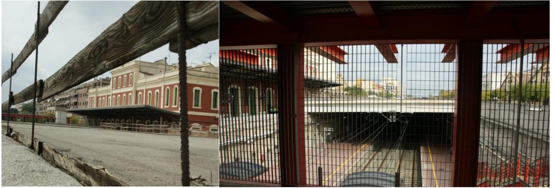
Figura 14. Vista de la plataforma de cubrició de la vía del ferrocarril en la estació de Vilafranca del Penedès antes de la actual reforma
